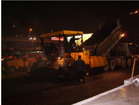
[2007, 서울시 도로 보수공사]
